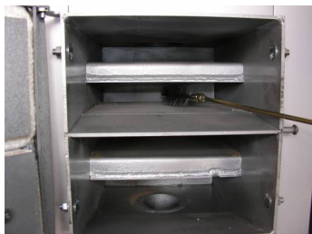
Fot.5. Powierzchnie wymiennika czyścić szczotką.
