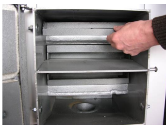
Fot.4. Wyjąć turbolizery spalin /12 i 18 kW/ i oczyścić je z pyłu.
