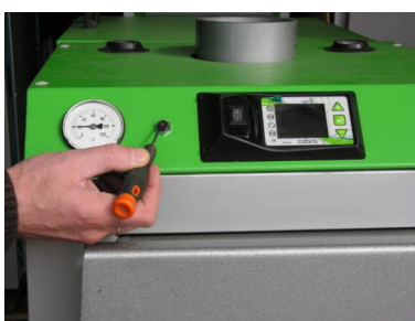
Fot.2. Śrubokrętem wcisnąć przycisk odblokowujący regulator.
