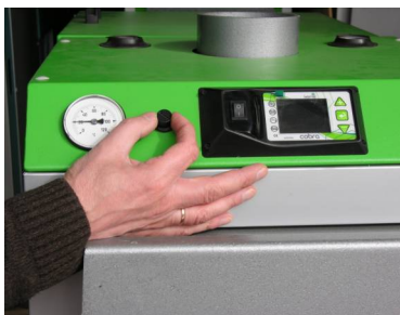
Fot.1. Odkręcić nakrętkę zaślepiającą ogranicznika STB.
