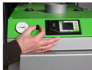
Fot.3. Zakręcić nakrętkę zaślepiającą ogranicznika STB.
