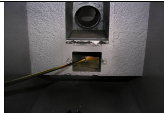
Fot.3. Zdjąć pokrywę wyczystki i opróżnić komorę powietrzną z popiołu.
