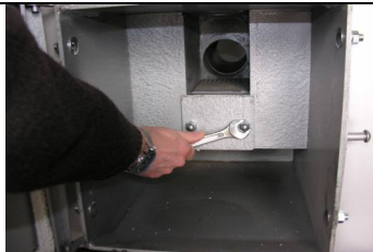
Fot.2. Odkręcić nakrętki pokrywy wyczystki komory powietrznej.
